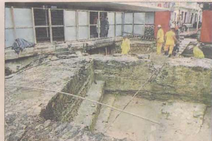
ACHADO Área da ruína, no Recife Antigo, ficará visível para o público
