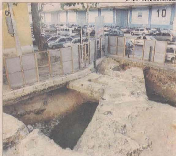
CAUSA Profundidade da escavação obriga técnicos a eguer proteção
